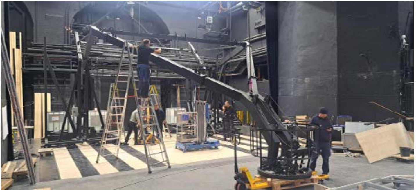
Für die Bewegung des Daches musste eine Konstruktion entwickelt werden, aus der nach längerer Planung ein Kran auf der Hinterbühne des Theaters wurde. Foto: Christoph Fath
